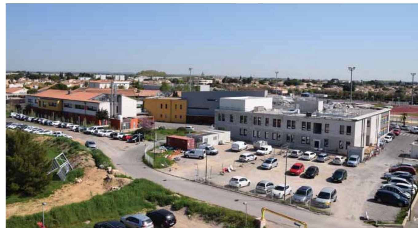
Création d'un troisième bâtiment
