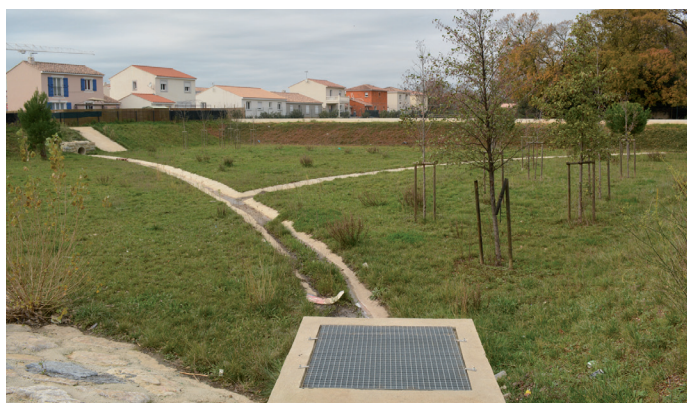
Des travaux pour améliorer l'évacuation des eaux pluviales.
