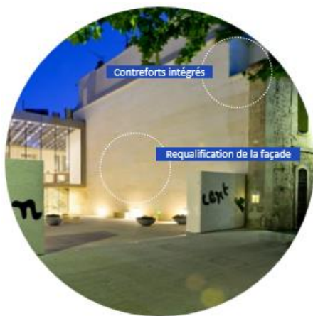
Traitement des contreforts et des façades mise à nue
