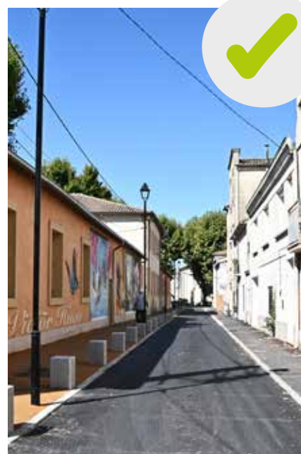
Réfection de voirie et piste cyclable, rue Lakanal
