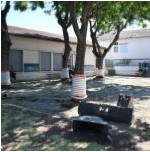
Ecole Maternelle Pont de Vesse – Travaux(1)
