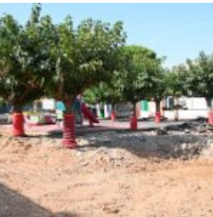
Ecole maternelle Arc en ciel – Travaux (4)
