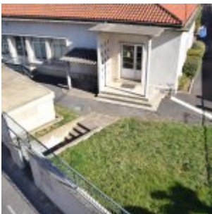
Ecole Maternelle Pont de Vesse – Avant (2)
