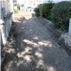
Ecole Maternelle Pont de Vesse – Travaux (2)
