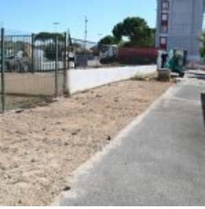
Ecole maternelle Arc en ciel – Travaux (1)
