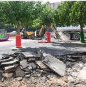
Ecole maternelle Arc en ciel – Travaux (3)
