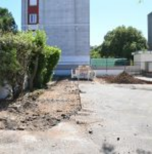
Ecole maternelle Arc en ciel – Travaux (2)
